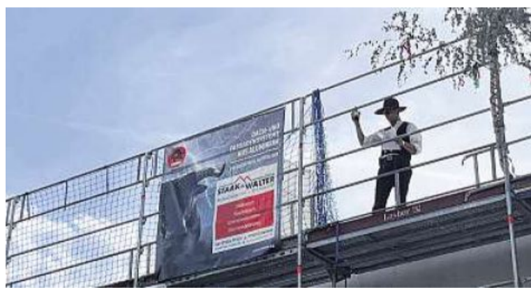
Die Bauarbeiten gehen voran: Schreiner Werner Eichelbröner beim Vortragen des Richtspruchs am Neubau der Kita in Estenfeld. FOTO: JULIAN BANDORF
