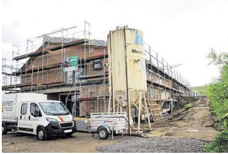
Der Neubau des Nordheimer Kindergartens ist weit fortgeschritten, die Kostenprognose kann laut Planungsbüro eingehalten werden. Im Januar 2023 ziehen die Kinder ein.
