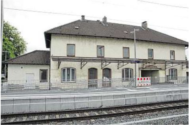
Heute eher unscheinbar, soll das Bahnhofsgebäude in Rottendorf wieder zum Hingucker werden.
