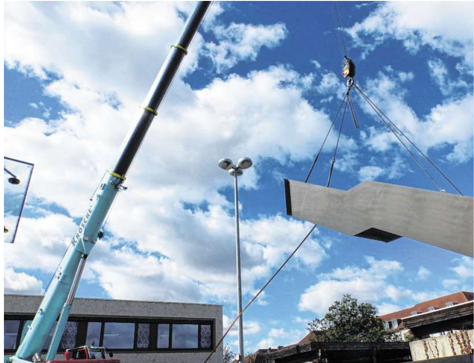
Fünf Tonnen schwerer Stahl, neun Meter lang. Wie ein riesiges Insekt hängt die Treppe in luftiger Höhe an den Kranseilen.
