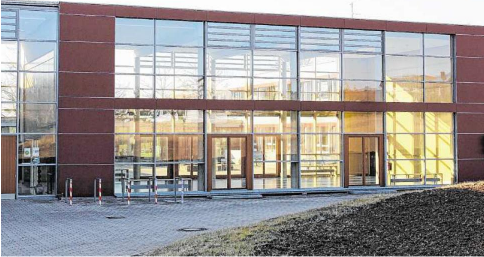
Die Grundschule in Kürnach erhält einen Anbau. Dort soll auch der dritte Kindergarten Platz finden.
