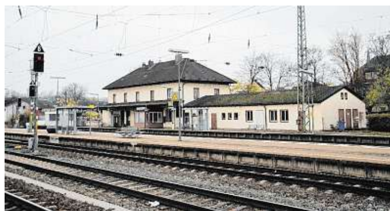
Der Bahnhof Rottendorf gehört zu den wichtigen Bahnhöfen in Unterfranken. Das Gebäude selbst ist derzeit weitgehend ungenutzt. FOTO: AMMON
