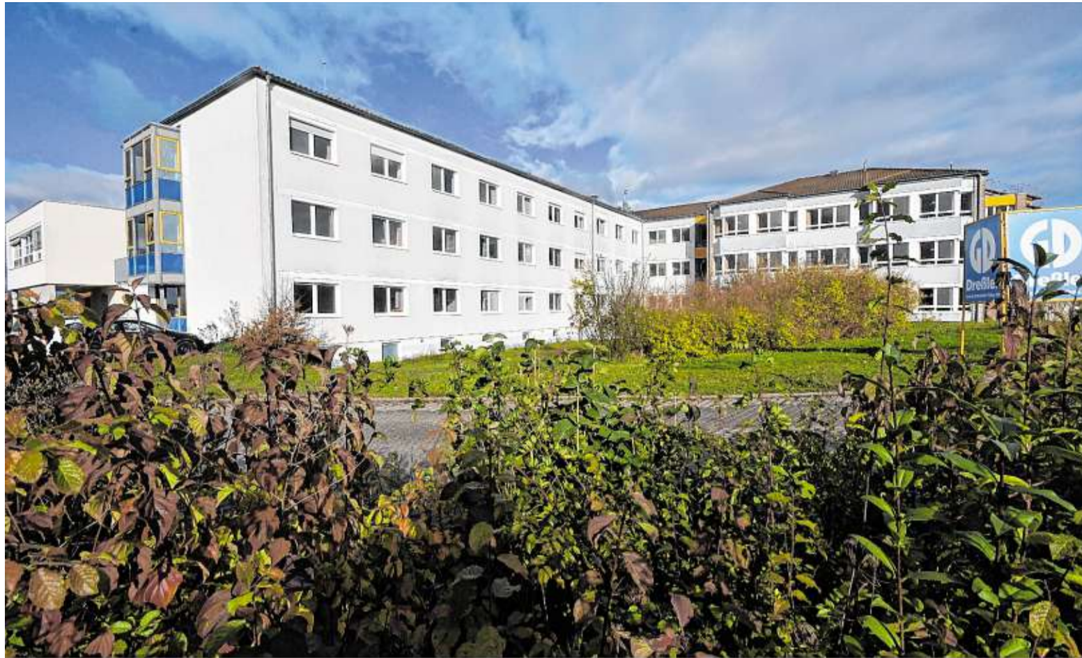
In einem ersten Schritt bei der Generalsanierung soll der Westflügel der Main-Klinik in Ochsenfurt (links im Bild) um einen neuen Pflegetrakt erweitert werden. FOTO: GERHARD MEISSNER
