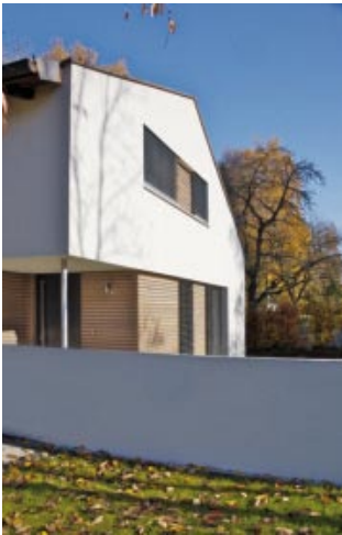
Wohnhaus Weigand, Gerolzhofen
