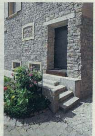
Heute kann man wieder die Bruchsteinfassade mit den historischen Gesimsen sehen.
