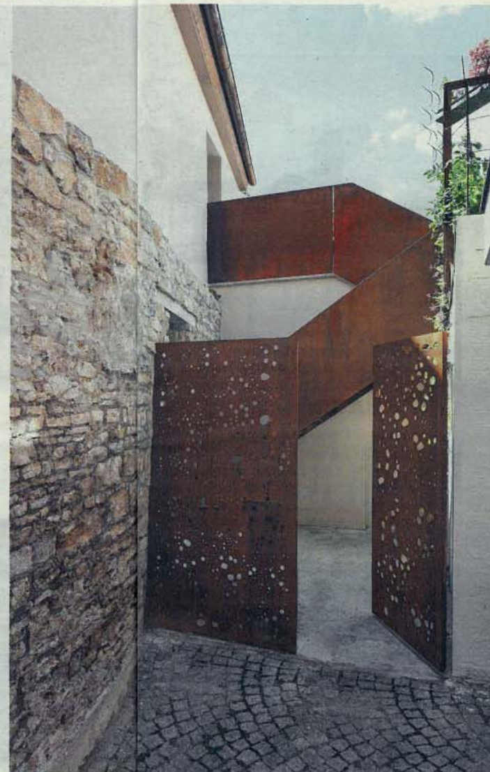
Der wetterfeste Baustahl des Eingangs mit seiner rostigen Patina passt sich der Rauheit der Natursteinfassade an.
