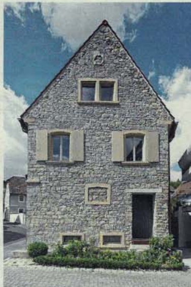
Mit der Zwei-Scheiben-Wärmeschutzverglasung der Fenster reduzierten die Planer den Energieverbrauch.
